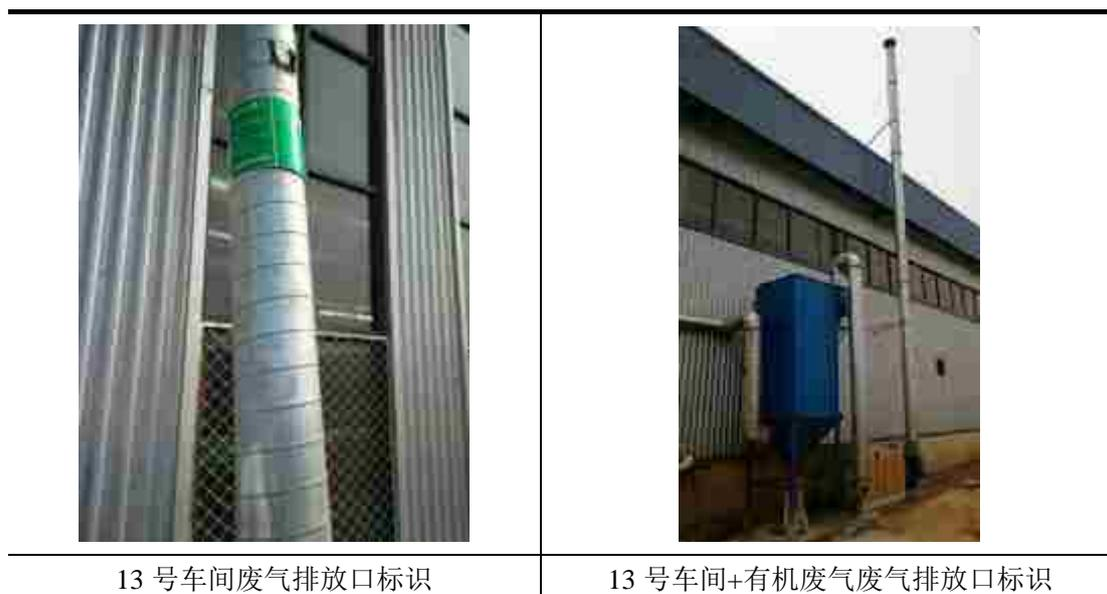
图 3-2 环保设备及排气筒现场照片
